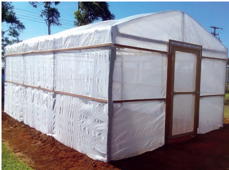
Figura 9. Estufa com cobertura de plástico e telado na lateral.
